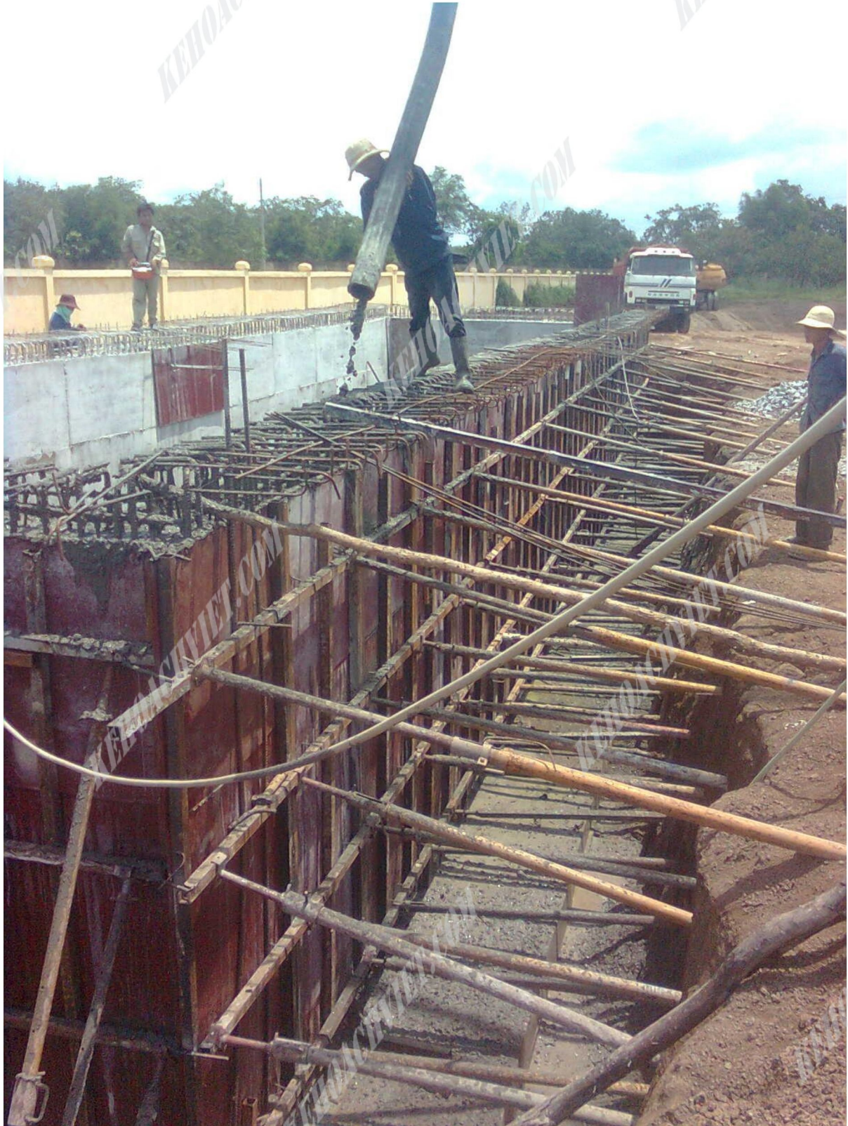
Đổ bê tông thành
