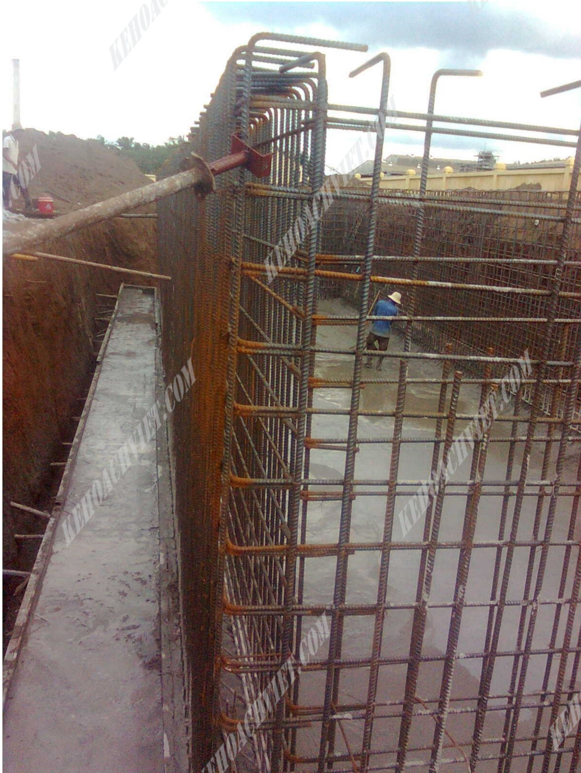
Hoàn thiện bê tông đáy
