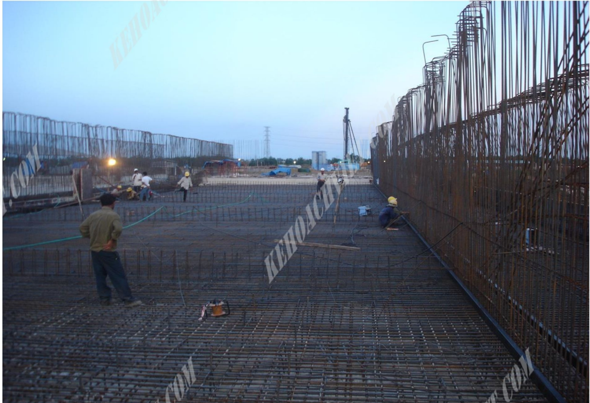
Thi công hệ thống xử lý nước thải
