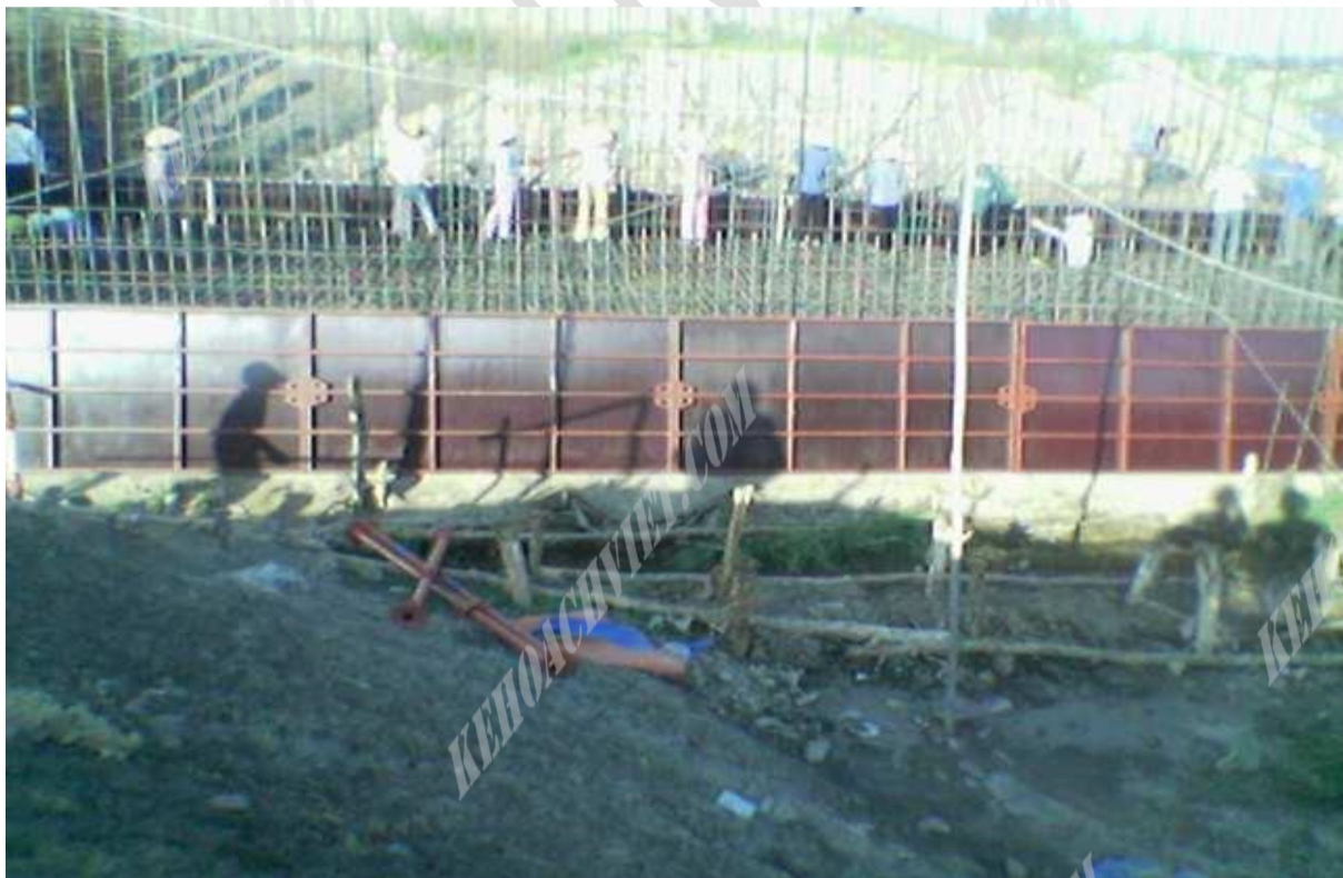
Lắp ghép ván khuôn móng nền và cốt thép tường
