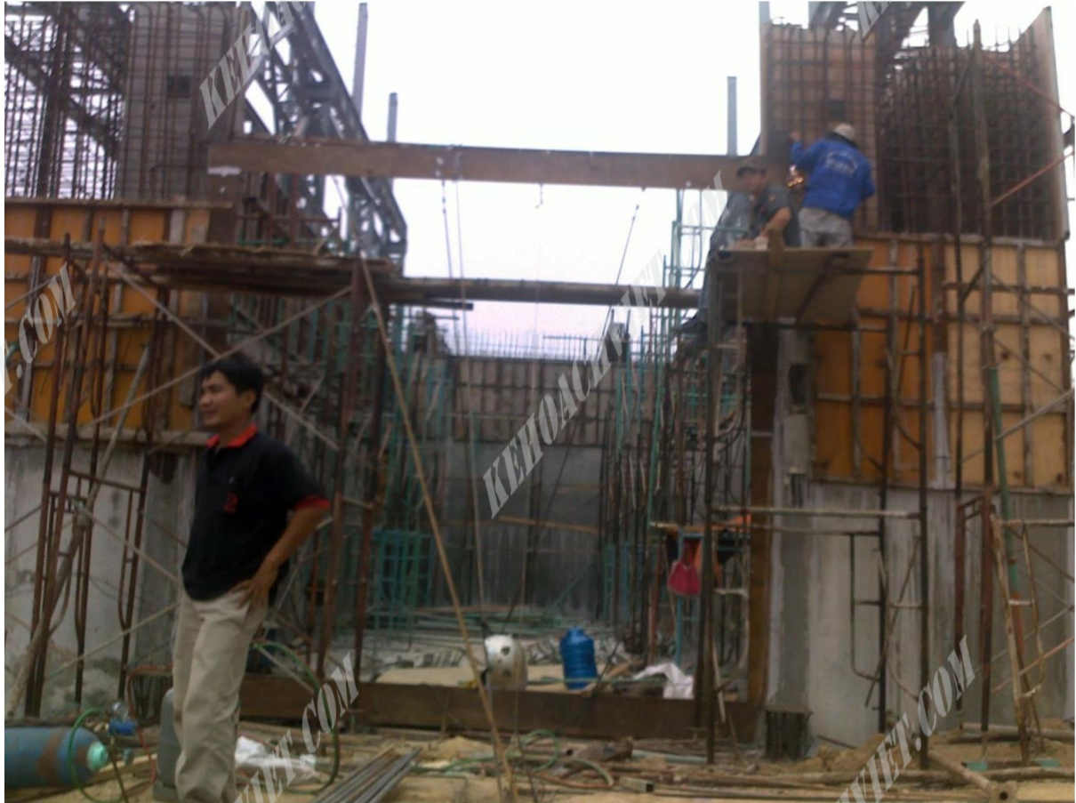
Thi công hệ thống xử lý bụi nhà máy luyện thép Xxxxxx 3
